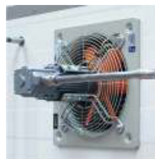
Sistema de Ventilación Forzada
